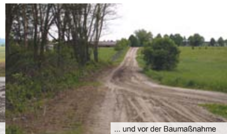
... und vor der Baumaßnahme
